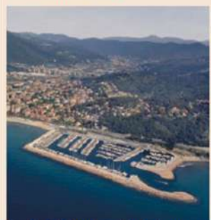
Porto di Andora. Veduta aerea
